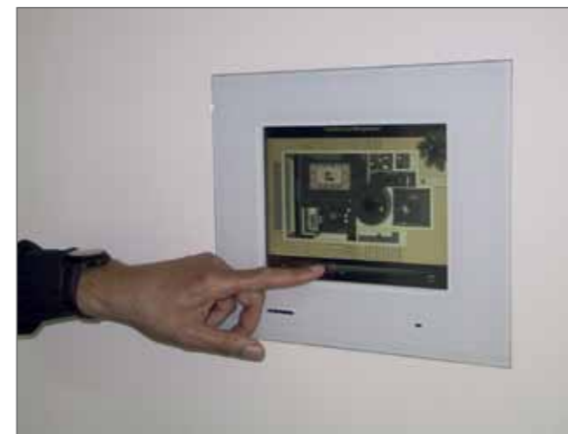
Panel PC mit Client-Version des Facility-Pilot: intuitive Bedienung an zentraler Stelle; Hintergrundplots und Grundrissbilder erleichtern zusätzlich die Steuerung
